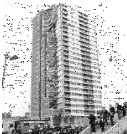
شکل ۱- ساختمان رونن پوینت
