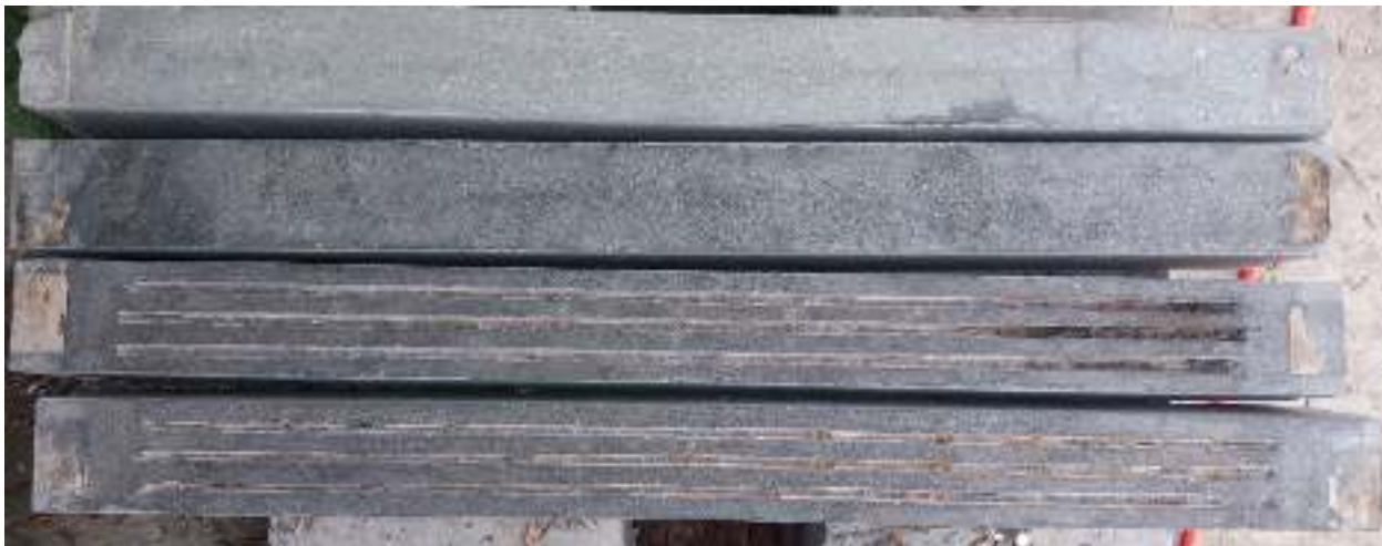
الف) آماده سازی سطح کششی تیرهای بتن مسلح به روش نصب خارجی و شیارزنی
