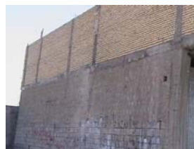
شکل ۱- استفاده ناصحیح از دو نوع مصالح باسختی‌های متفاوت در ساخت دیوار باربر در بهبهان
