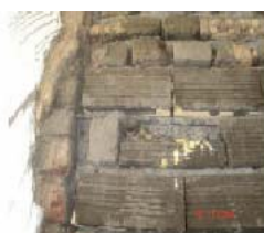
شکل ۲۴ الف وب - تعبیه روکش بتن مسلح در یک وجه یا دو وجه دیوار
