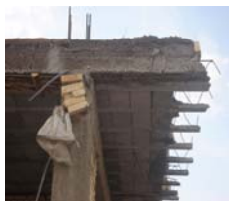
شکل ۵- پس از اجرای شنازها سقف بر روی آن اجرا شده
