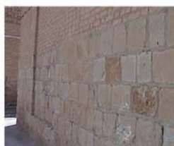
شکل ۱- استفاده ناصحیح از دو نوع مصالح باسختی‌های متفاوت در ساخت دیوار باربر در بهبهان
