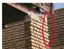
شکل ۲۲- پیوند هشت گیر در اجرای دیوارها در ساختمان سازی بهبهان که از عوامل مهم شروع ترک ها پس از زمین لرزه به شمار می رود.
