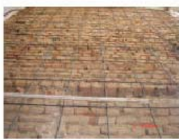
شکل ۲۴ الف وب - تعبیه روکش بتن مسلح در یک وجه یا دو وجه دیوار
