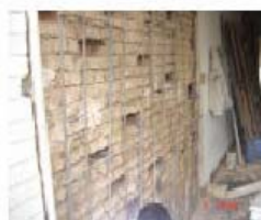
شکل ۲۴ الف وب - تعبیه روکش بتن مسلح در یک وجه یا دو وجه دیوار
