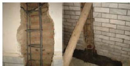
شکل ۲۶ - تعبیه کلافهای قائم در ساختمان
