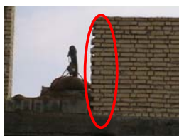
شکل ۲۲- پیوند هشت گیر در اجرای دیوارها در ساختمان سازی بهبهان که از عوامل مهم شروع ترک ها پس از زمین لرزه به شمار می رود.
