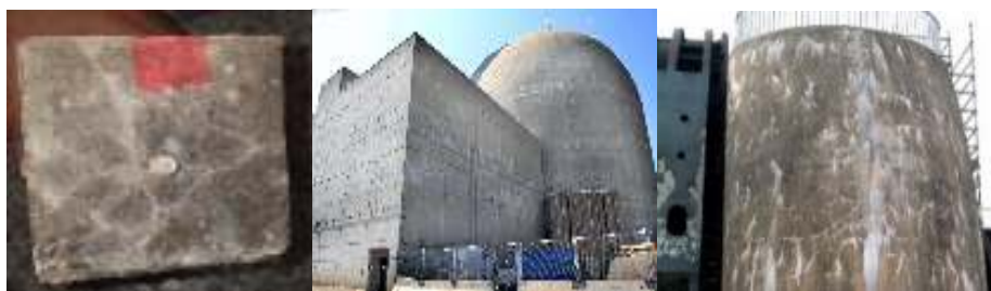
شکل ۱- ترک خوردگی سطحی و پاشیدگی ژل سفید رنگ بر اثر واکنش قلیایی - سیلیسی بر روی سطح بتن
